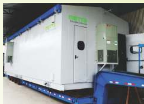
Eletrocentro para fixação sobre pilares.
