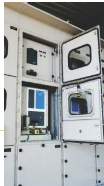
Cubículo com Contator
